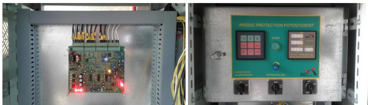
شکل ۴. پتانسیواستات حفاظت آندی ساخت شرکت برنالکترونیک
