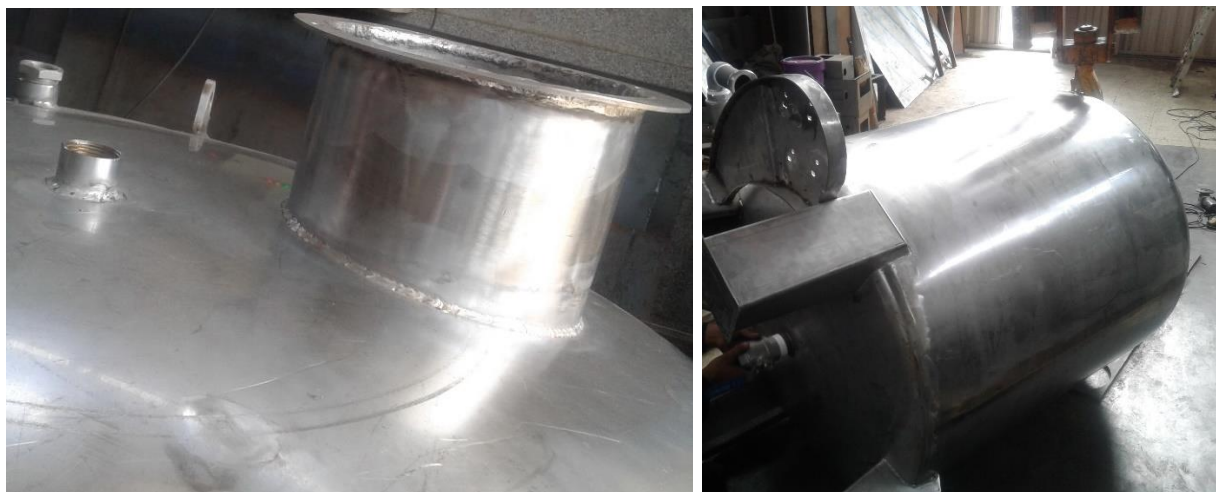
شکل ۳. مخزن ذخیره‌سازی اسید در حال ساخت
